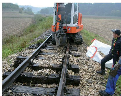
Schwellentausch geht mit Bagger und Wasser wie geschmiert.
