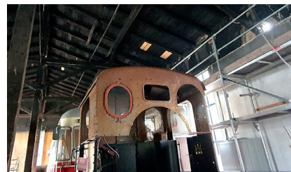
Hier strahlt es noch nicht so hell, Anfang September sind die Verputzarbeiten noch in vollem Gange.
